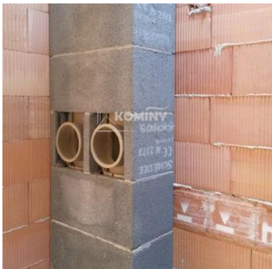
Obrázek 6 Napojení sopouchu a dvířek (Komíny Kašpar, Dodatečné napojení sopouchu a dvířek, [online], 2014, [cit. 2014-15-09]. Dostupný z: http://www.kominy-kaspar.cz/www-9-dodatecne-napojeni-sopouchu-a-dvirek )
