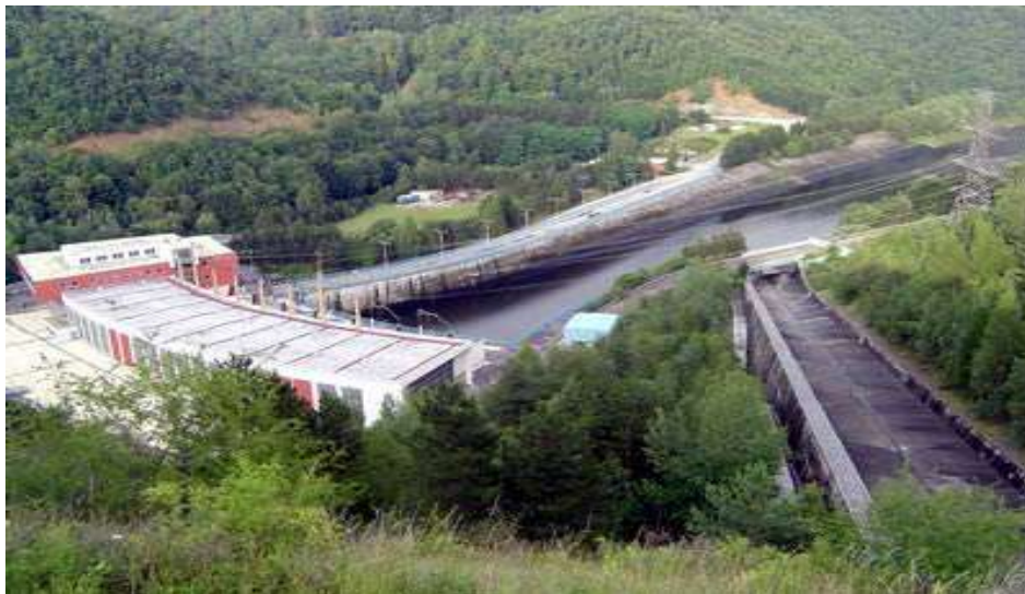
Obr. 11 Vodní elektrárna Dalešice
