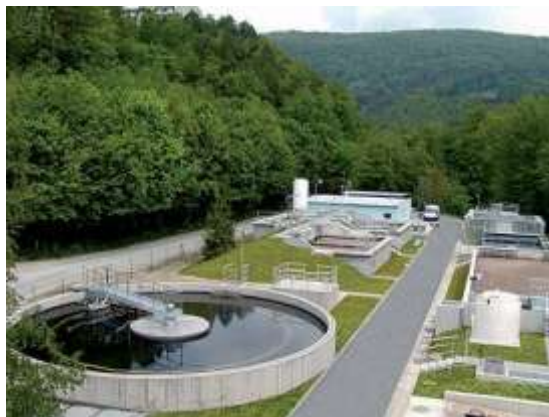
Obr. 4 Čistička odpadních vod
